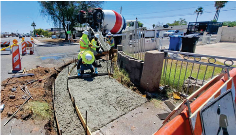
Los equipos de construcción están instalando cientos de rampas en las banquetas de la ADA en toda la ciudad, eliminando las barreras a la movilidad de las personas con discapacidades.
